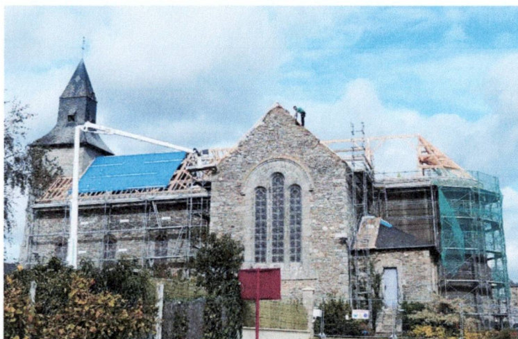
2022 : Pose nouvelle charpente en bois
