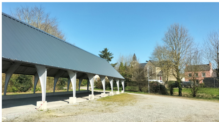
La halle et ses environs à aménager
